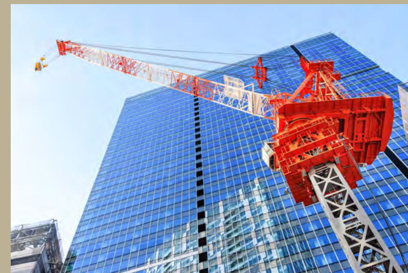
タワークレーン Tower Crane
